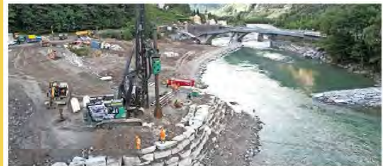
22 Meter tiefe Grossbohrpfähle mit einem Durchmesser von 1,2 Metern erstellt, bewehrt und mit Beton ausgegossen: Die Birchmeier Spezialtiefbau AG aus Dagmersellen erstellte die Fundamente für jene Notbrücke, welche die Sappeure der Schweizer Armee in diesen Tagen aufbauen, damit im oberen Maggiatele schwere Maschinen für die Räumung der Unwetter auffahren können. freeswag
